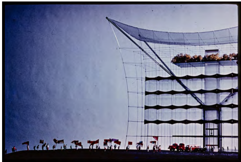
Raumnetz-Hochhaus 9×9×3 vertikal, Netz mit „Gabel“-Stützen, 1970
