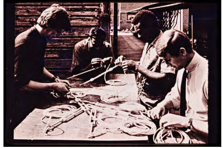
Erster Versuchsbau eines Raumnetzes aus Stahlseilen mit Studenten der School of Architecture Portsmouth, UK, 1967
