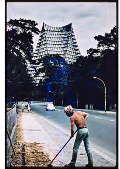
Terrassenhäusern mit in Raumnetzstrukturen eingehängten Raumzellen
