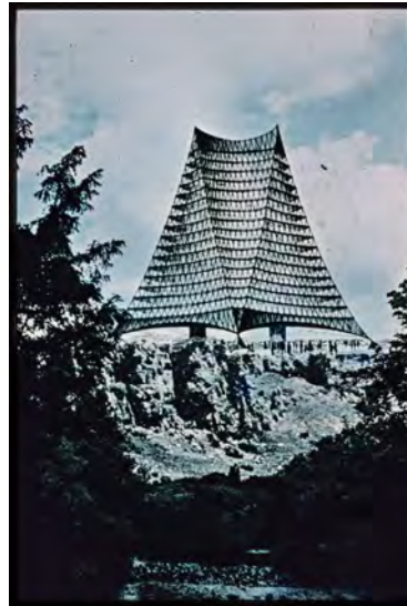
Terrassenhäusern mit in Raumnetzstrukturen eingehängten Raumzellen
