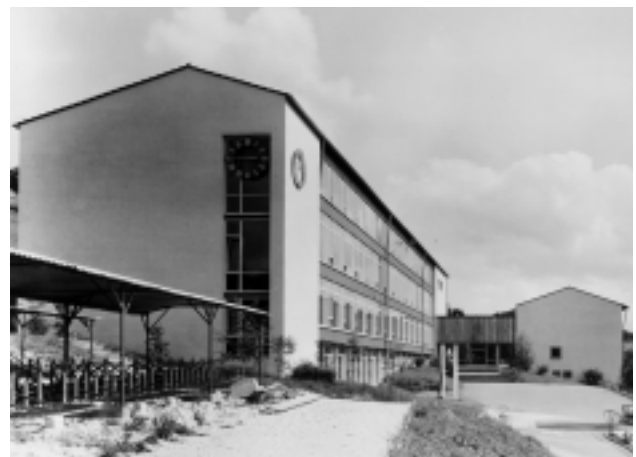
Taiflingen, Schulen am Lammerberg: Volksschule, Mittelschulen Kindergarten und Schwimmhalle, Wettbewerb 1950 (mit E. Heinle) und Ausführung (in Arbeitsgemeinschaft mit K. Häge, Schwäbisch Gmünd) 1950-53
