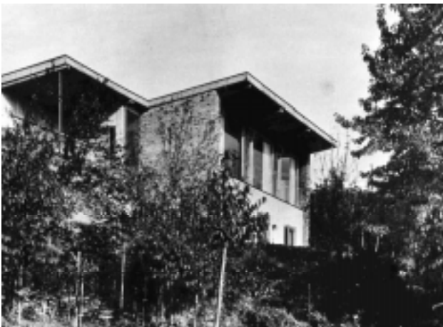
Esslingen, Wohnhaus Dr. Finckh, 1949/51, Anbau 1955/56
