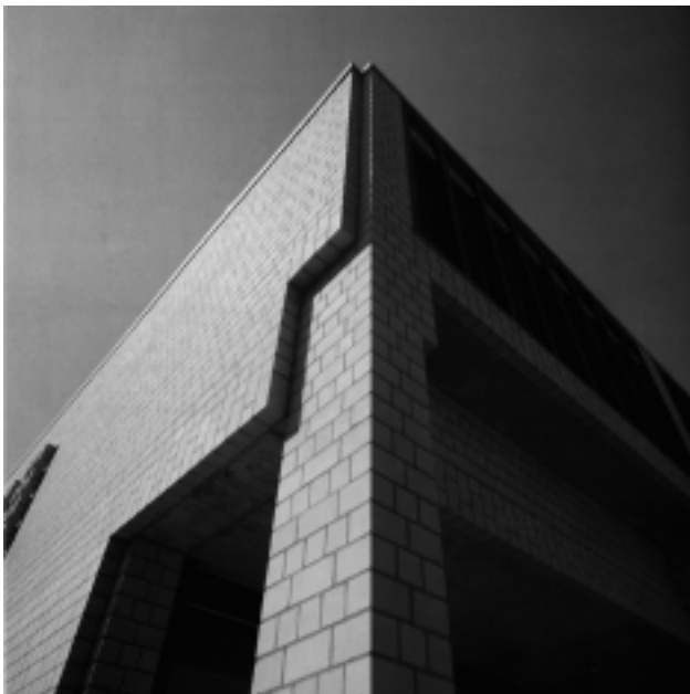
Bürohaus Mohl Karlsruhe-Bergwald 1972-74 (WV 80)
