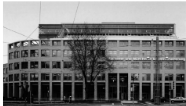
Umbau und Erweiterung Verwaltungsgebäude Aachener und Münchener Versicherungen Karlsruhe 1992-95 (WV 213)
