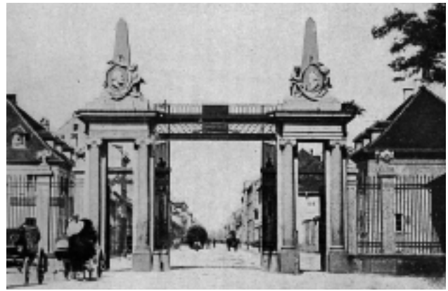
3 Blick von Osten auf das Durlacher Tor, Foto vor dem Abbruch 1875
