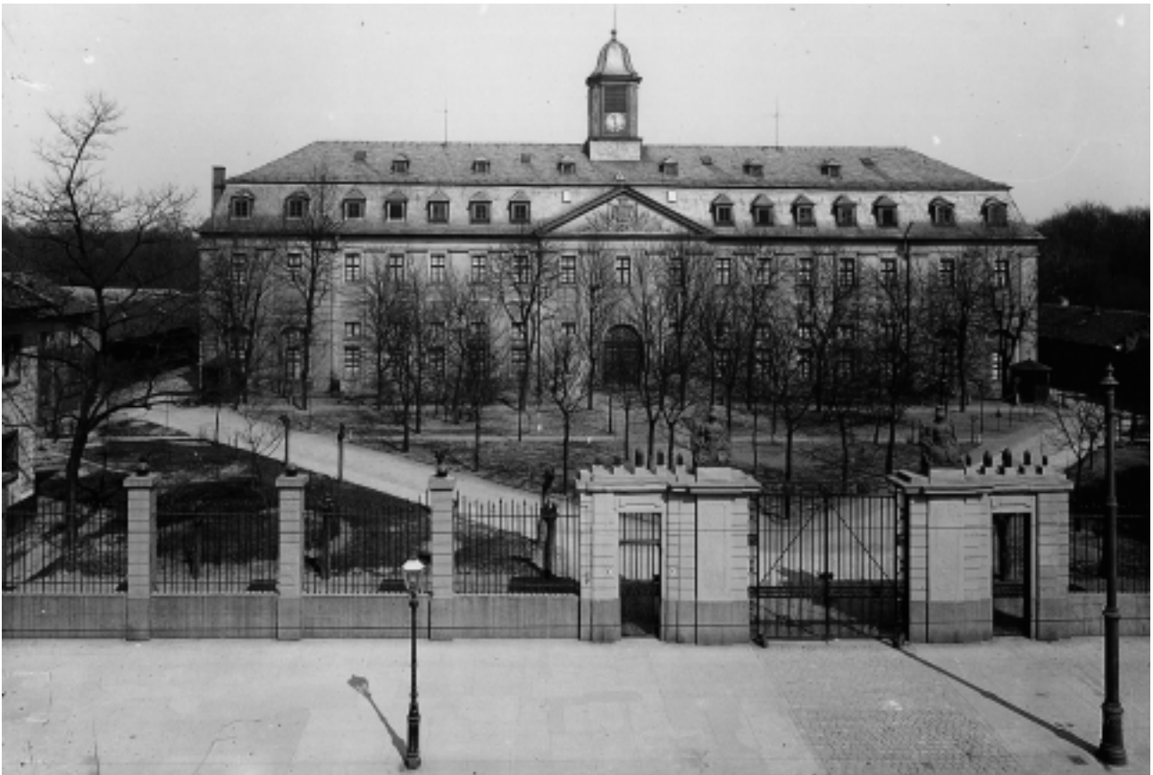
12 Blick auf das Zeughaus mit Vorhof und Einfriedung zur Kaiserstraße, Foto vor 1920
